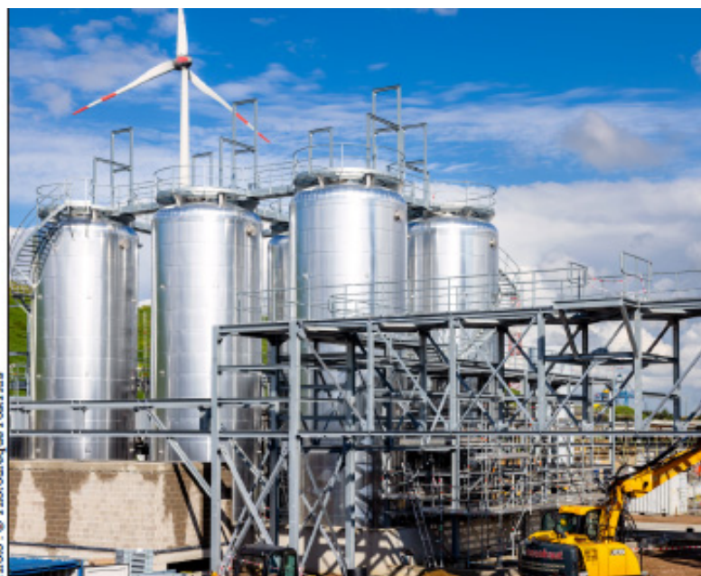
Le document du ministère parle de « massification du soutien des éco-organismes à l'investissement industriel ». On croit comprendre qu'il s'agit de soutenir notamment le recyclage chimique. En photo, construction d'une usine Indaver en Belgique.
